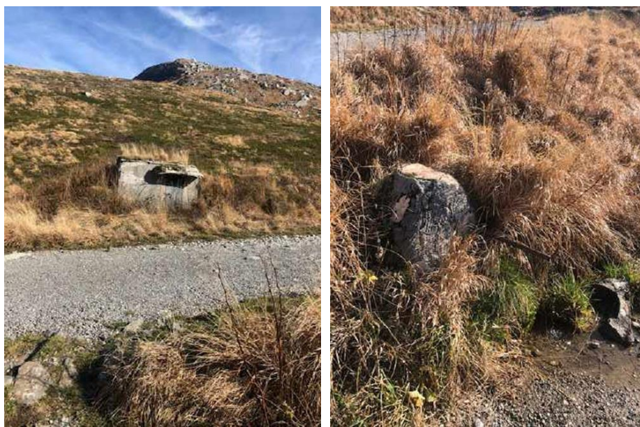
Figura 39 - Opera di captazione e suo deflusso verso valle
